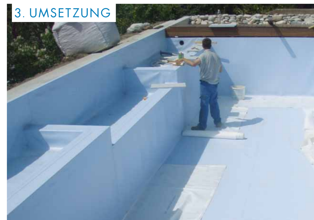
Abdichtung durch maßverlegte Schwimmteich-Folien: Natursteinbeläge und Natursteinmauern tragen zu einer harmonischen Gesamtlösung bei.
