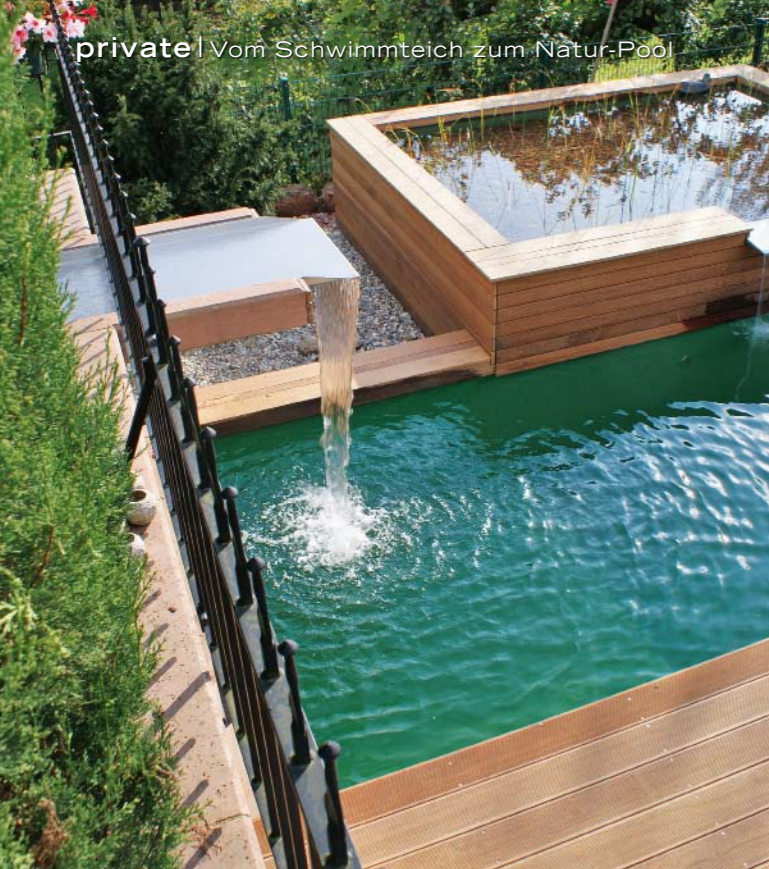
Auf verschiedenen Ebenen: Das Filterbecken für die biologische Wasseraufbereitung liegt leicht erhöht über dem Schwimmbecken.
